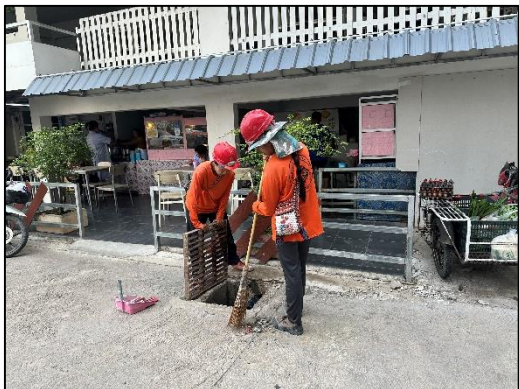
ภาพที่ 30 เจ้าหน้าที่ดูแลตรวจสอบท่อระบายน้ำ
