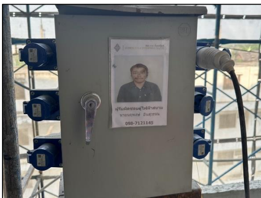
ภาพที่ 61 ตู้ไฟฟ้าสนาม และผู้รับผิดชอบ (ช่างเทคนิคไฟฟ้า)
